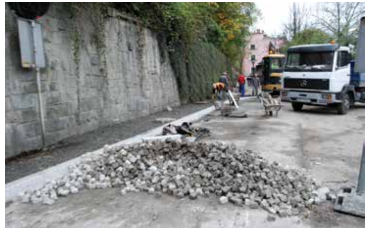
Ulica Przykopa niedługo pochwali się nowym, brukowanym chodnikiem.
