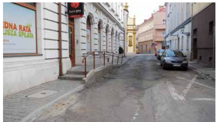
Kostka brukowa zastąpiła zniszczony asfalt na ulicy Szerokiej.
